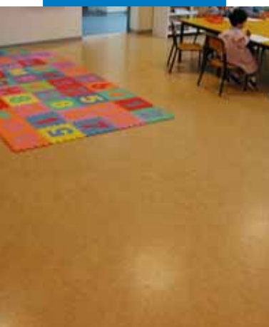
Линолеум, уложенный на стяжку, предварительно выровненную Ultraplan Eco, детский сад "Мирабэлло", Канту, Италия
