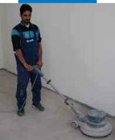
Подготовка основания шлифовальной машиной перед нанесением Ultraplan Eco, детский сад "Мирабэлло", Канту, Италия
