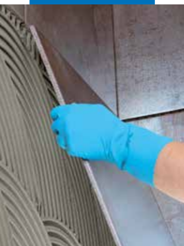
Укладка плит крупного формата на стены
