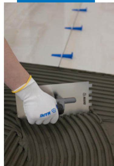
Укладка на пол керамогранита размером 160 x 80 см
