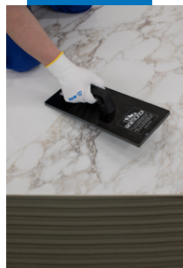
Укладка керамогранита размером 240 x 120 см.
