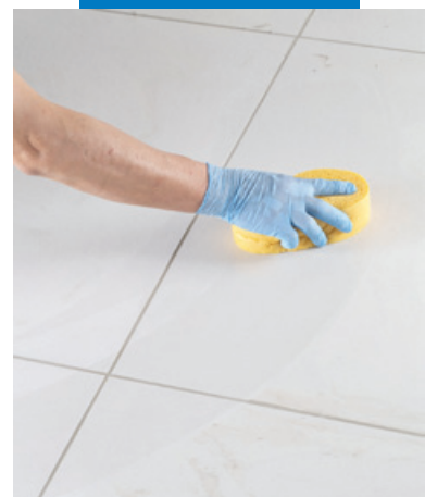
Окончательная очистка плитки с помощью целлюлозной губки
