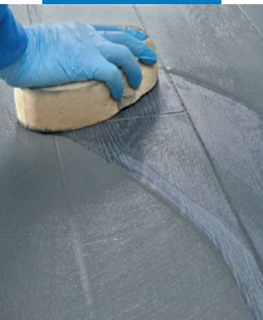
Окончательная очистка плитки с помощью целлюлозной губки
