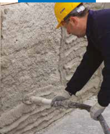
Применение PoroMap Deumidificante с помощью машины для рендеринга
