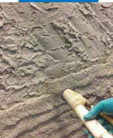
Нанесение PoroMap Deumidificante с помощью штукатурной машины
