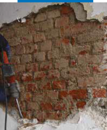
Подготовка основания - удаление существующей штукатурки
