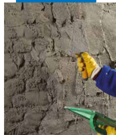
Нанесение шпателем
