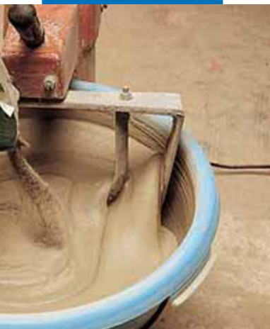
Смешивание серого Planiseal 88 с водой
