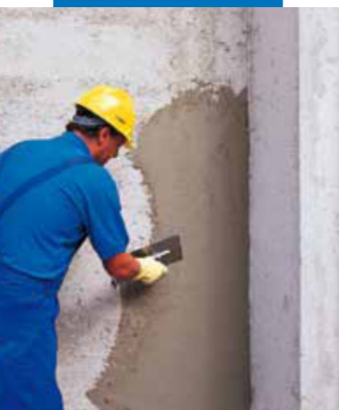
Нанесение шпателем
