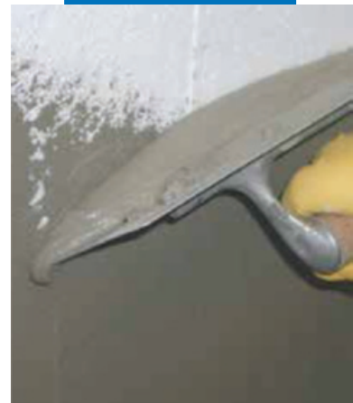
Нанесение базового штукатурного слоя
