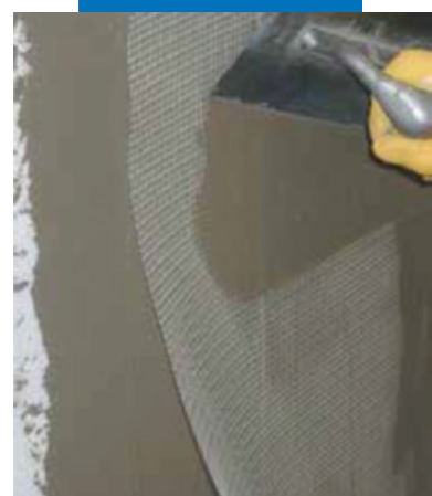
Армирование базового штукатурного слоя
