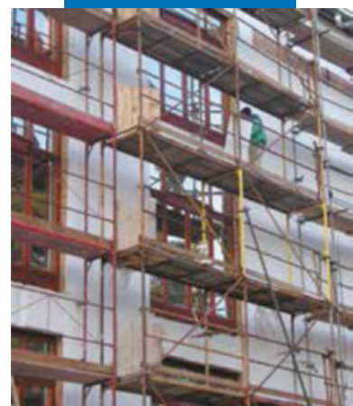
Монтаж системы утепления на фасаде здания
