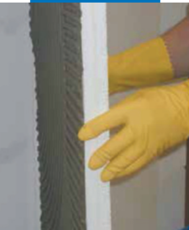
Монтаж теплоизоляционной панели
