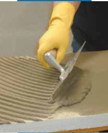
Нанесение растворной смеси Mapetherm AR2 на тыльную сторону теплоизоляционной панели
