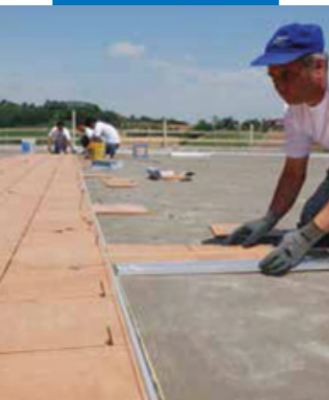
Укладка керамической плитки с применением Kerabond T-R + Admix I
