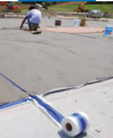
Гидроизоляция стяжки с применением Mapelastic и Mapeband
