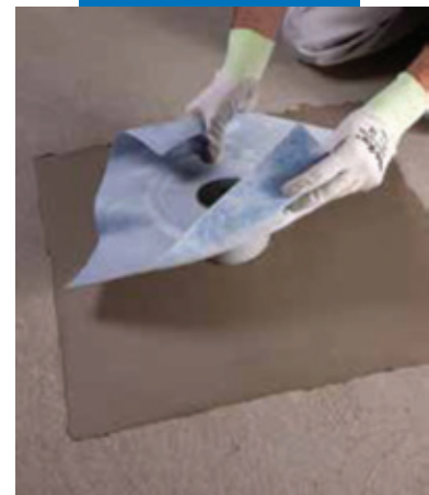
Установка вертикального дренажа на Mapelastic
