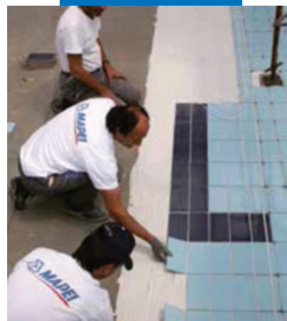
Укладка керамической плитки на Mapelastic в бассейне
