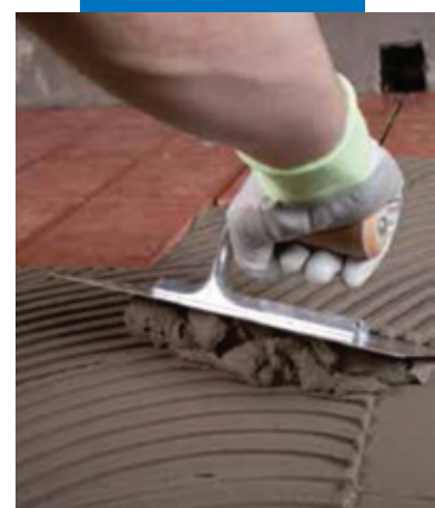
Нанесение Granirapid на гидроизоляцию Mapelastic на террасе
