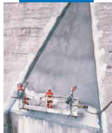
Нанесение Mapelastic на дамбу распылением
