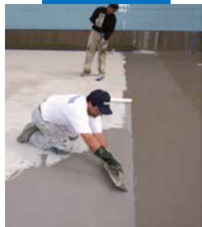
Гидроизоляция бассейна с применением Mapelastic
