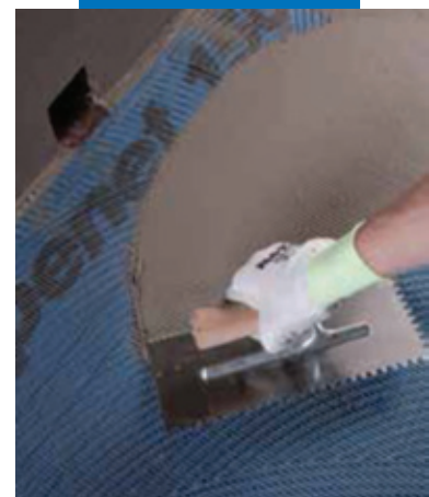
Нанесение Mapelastic на Mapenet 150 R
