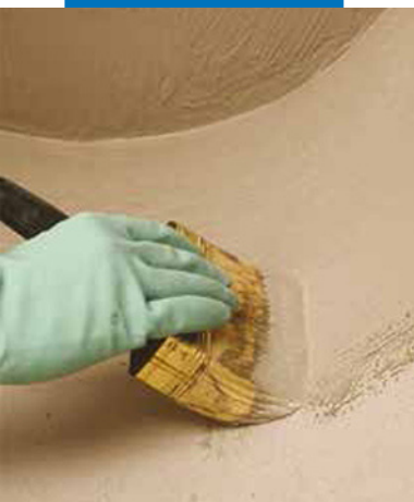
Нанесение гидроизоляции с помощью кисти
