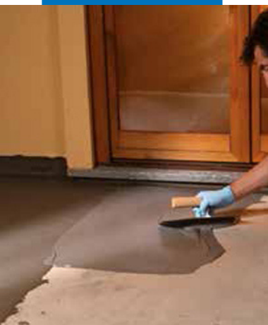
Нанесение гидроизоляции на террасе с помощью шпателя
