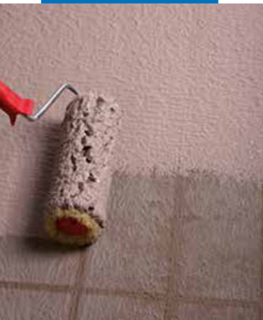
Нанесение гидроизоляции с помощью валика
