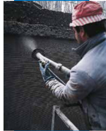
Механизированное нанесение методом мокрого торкретирования
