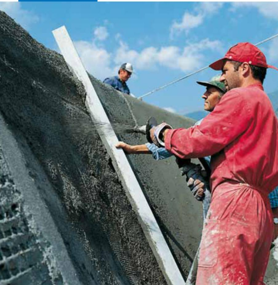
Механизированное нанесение MapregrouT40
