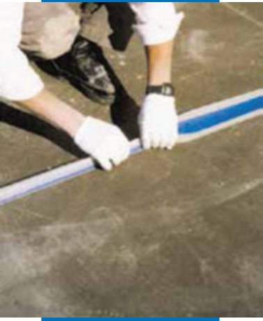
Пример гидроизоляции деформационного шва на террасе
