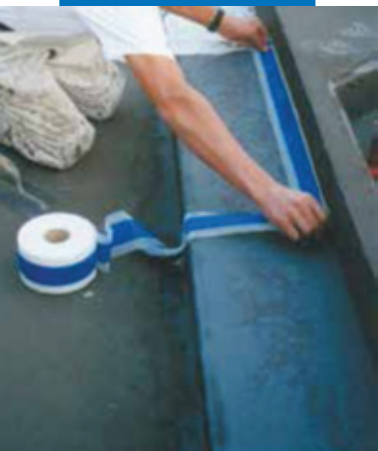
Пример гидроизоляции угла между нижней и боковой частью ванны с помощью Mapeband
