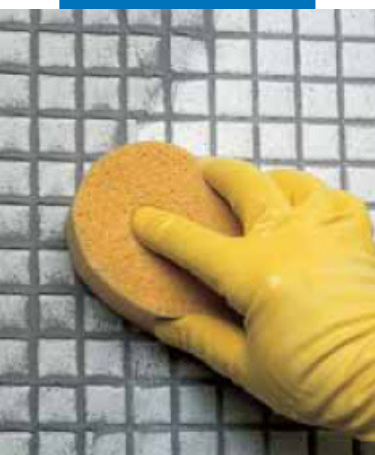
Очистка стеклянной мозаики губкой
