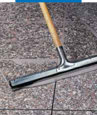
Заполнение швов в гранитных полах резиновой раклей
