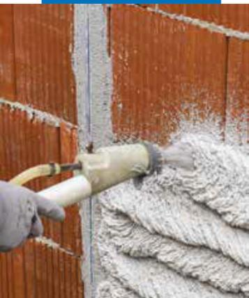
Нанесение Intomap 535 с помощью штукатурной станции
