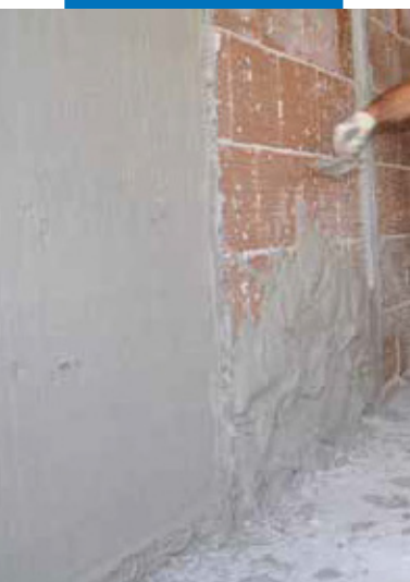
Нанесение Intomar 340 вручную
