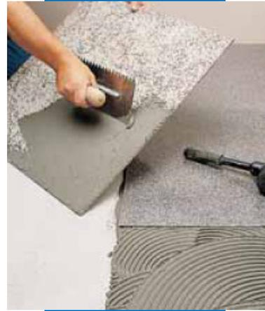
Укладка гранита с помощью серого Granirapid
