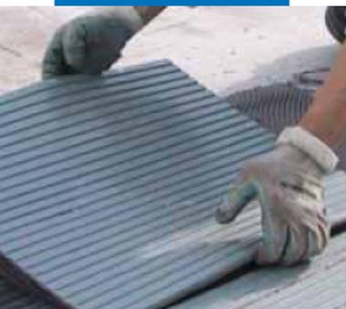
Укладка резиновой плитки с профилированной тыльной стороной с помощью клея Granirapid
