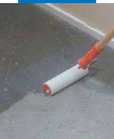
Нанесение ADMIX MF валиком
