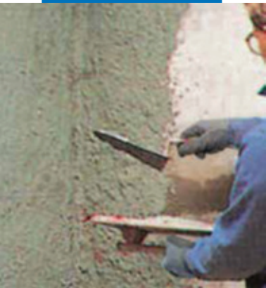
Нанесение адгезионной штукатурки с добавлением ADMIX P
