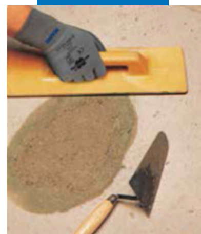
Ремонт пола: заглаживание поверхности
