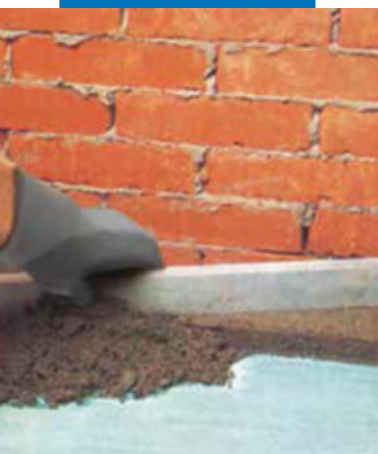
Укладка цементной стяжки с добавлением ADMIX P
