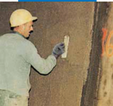
Использование цементной штукатурки с добавлением ADMIX P в строительстве автодорожного туннеля в Виль-Мари, Монреаль, Канада
