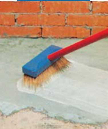
Нанесение цементного раствора с добавлением ADMIX P
