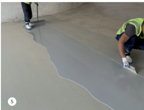
3-5. Устройство полиуретанового покрытия ramпы паркинга Mapecolor Parking System HE
