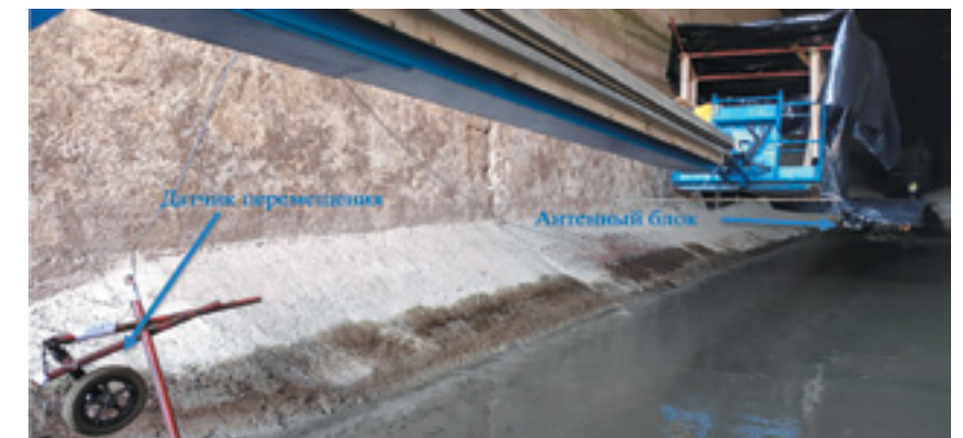
Рис. 4. Обследование туннелей посредством георадиолокационной системы
