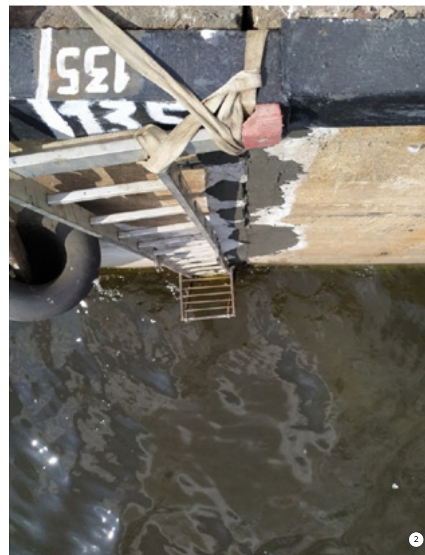
2. Порт Усть-Луга в Кингисеппском районе Ленинградской области: восстановление нижней части железобетонного оголовка причалов №1 и №3.
