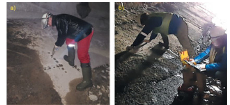
Рис. 3. Обследование поврежденных участков туннелей неразрушающими методами: а) испытания методом упругого отскока; б) ультразвуковые исследования
