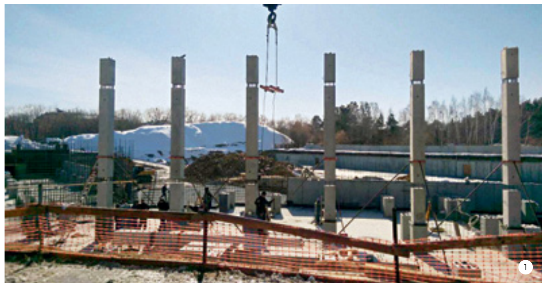
1. Установка сборно-монолитных колонн 2. Укладка смеси на торец колонны 3-4. Процесс монтажа 5. Наши материалы применялись при строительстве жилого микрорайона «Западный луч» в Челябинске
