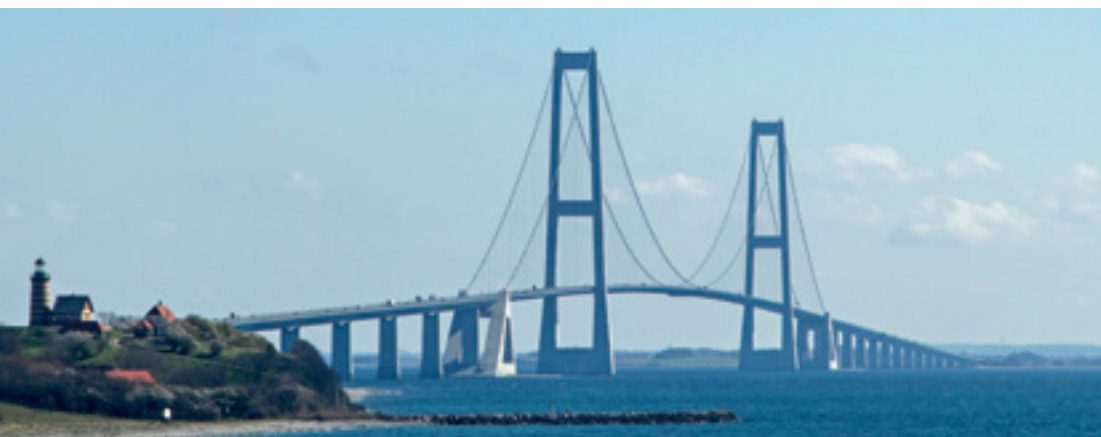
При строительстве моста Большой Бельт в Дании использовался MAPEFILL для анкеровки и MAPELASTIC для гидроизоляции.
