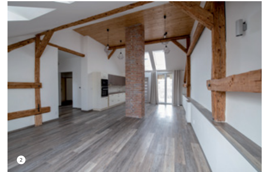
1. После нанесения гидроизоляционного состава Monolastic для облицовки ванной комнаты LVT-покрытием использовали Ultrabond Eco MS 4 LVT Wall с последующим нанесением защитного слоя Mapecoat 4 LVT. 2. Система, состоящая из Primer G, Planitex D5 и Ultrabond Eco V4SP Fiber, была выбрана для укладки полов из LVT на кухне.
