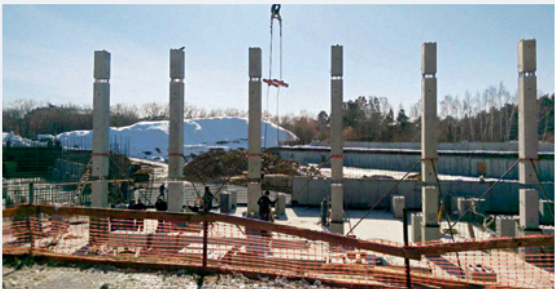
Фото 1. Установка сборно-монолитных колонн.
