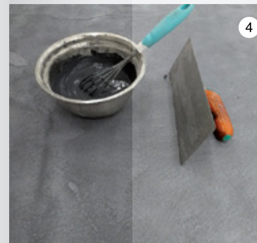
1, 2. Офисный центр JetBrains в Приморском районе Санкт-Петербурга. 3-6. Устройство декоративных напольных покрытий Ultratop Loft.
