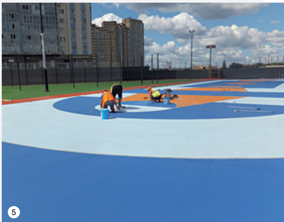
1-5. Укладка резиновых матов на клей и нанесение базовых и финишных слоев системы Mapescoat TNS Multisport Comfort
