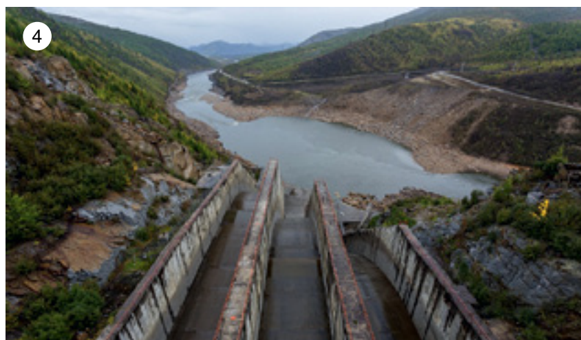
1-4. Применение линейки материалов MAPEI для ремонта и антикоррозийной защиты конструкций
