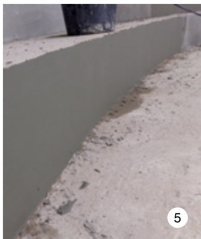
4. Ремонт ступеней и углов трибун при помощи Mapegrout Fast Set R4 и Mapegrout 430 5, 6. Подготовка трибун под финишную укладку Ultraplan Eco
