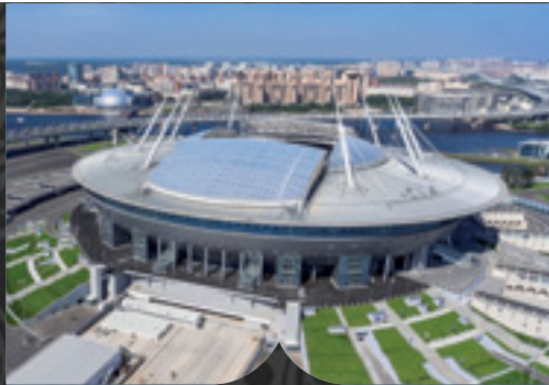
САНКТ-ПЕТЕРБУРГ Стадион Санкт-Петербург
