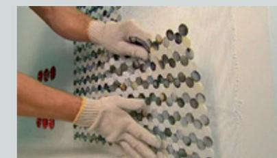
Швы должны быть чистыми, очищенными от пыли и пустыми на глубину не менее чем 2/3 от толщины плитки. Любой клей или строительный раствор, оставшийся в швах при укладке плитки, следует удалить, пока он остаётся свежим. Перед заполнением швов убедитесь в том, что кладочный раствор или клей затвердели, а также, что большая часть влаги испарилась. Kerapoxy
