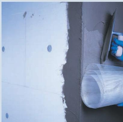
Укладка сетки Mapetherm Net
