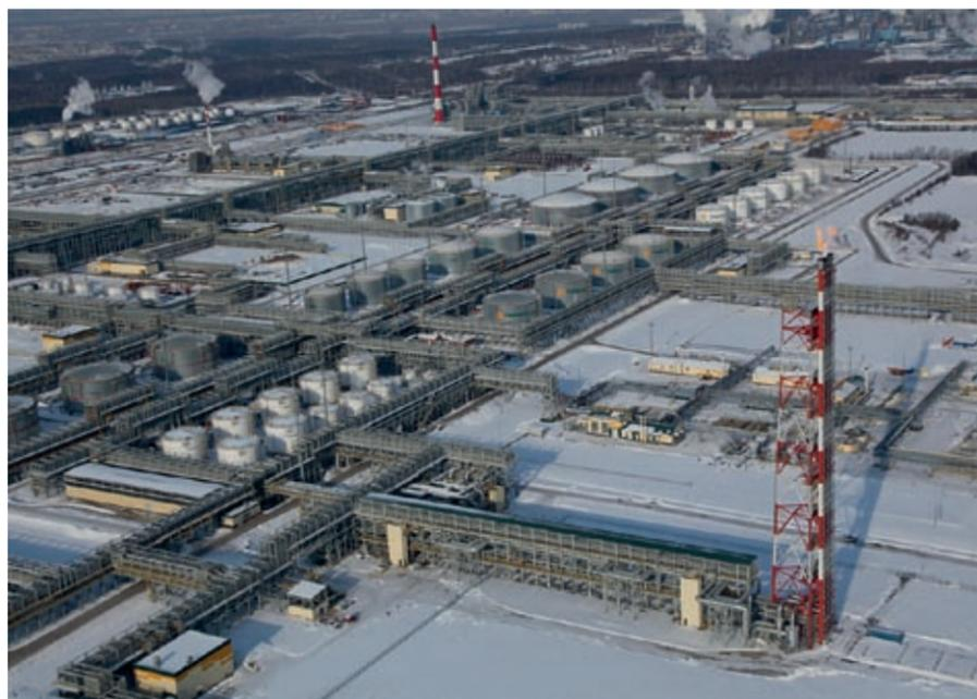
2. Завод глубокой переработки нефти, состоящий из установок замедленного коксования, производства водорода, гидрокрекинга тяжелых дистиллятов, гидроочистки тяжелого газойля коксования, каталитического флюидкрекинга, сернокислотного алкилирования, регенерации серной кислоты, газификации нефтяного кокса и когенерации, производства базовых масел.
