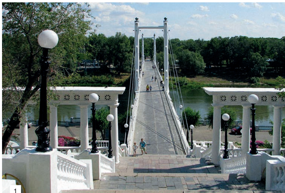
Фото 1, 2. Пешеходная зона на набережной реки Урал.
