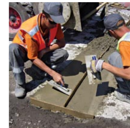
Укладка и выравнивание АРБ-10Ф
