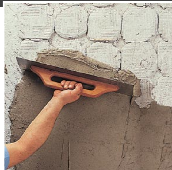
Нанесение Nivoplan Plus
