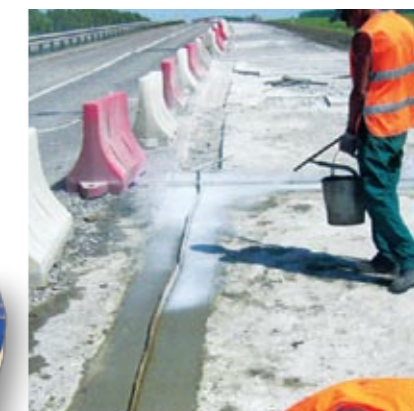
Нанесение пленкообразующего состава Mapecrete E
