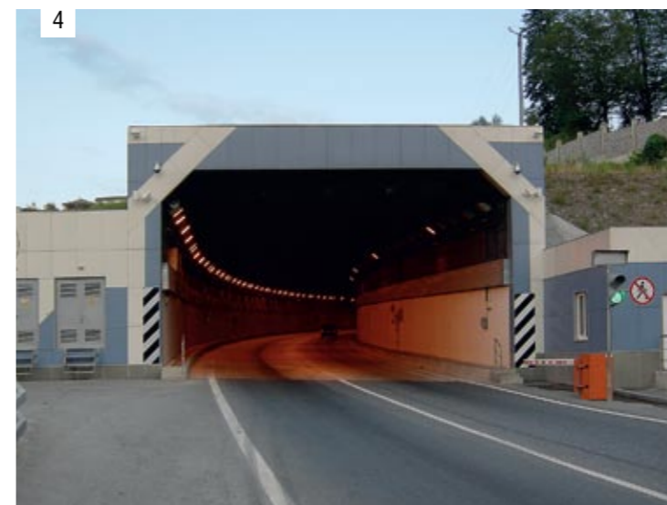
Фото 3, 4. Въезды в тоннель
