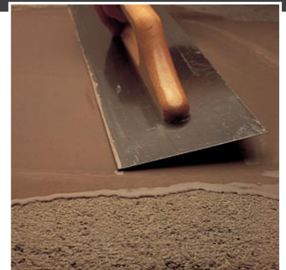
Нанесение Ultraplan Eco20
