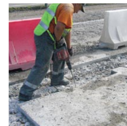
Подготовка бетонного основания
