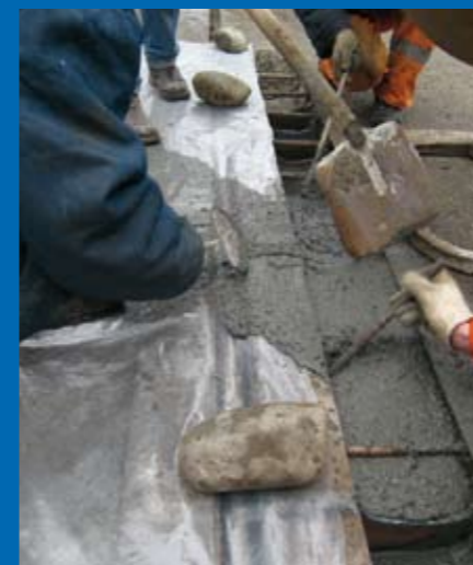
Укладка Mapegrout SF с уплотнением путем штыкования
