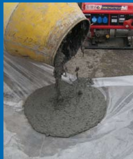
Замешивание и визуальное определение подвижности Mapegrout SF
