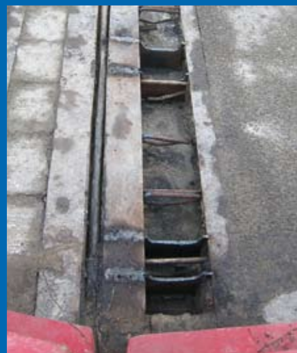
Подготовка шва перед заполнением Mapegrout SF
