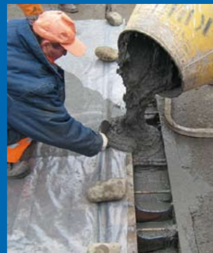
Укладка Mapegrout SF
